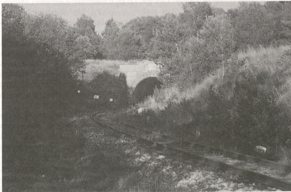
Tunel pod przełęczą Łupkowską. Fot. J. Montusiewicz
