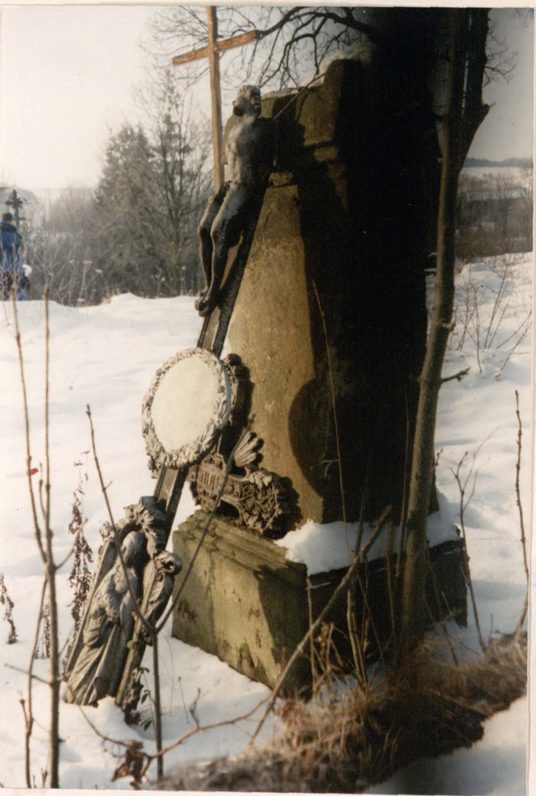
USZKODZONY NAGROBEK NA CMENTARZU W PIORUNCE
