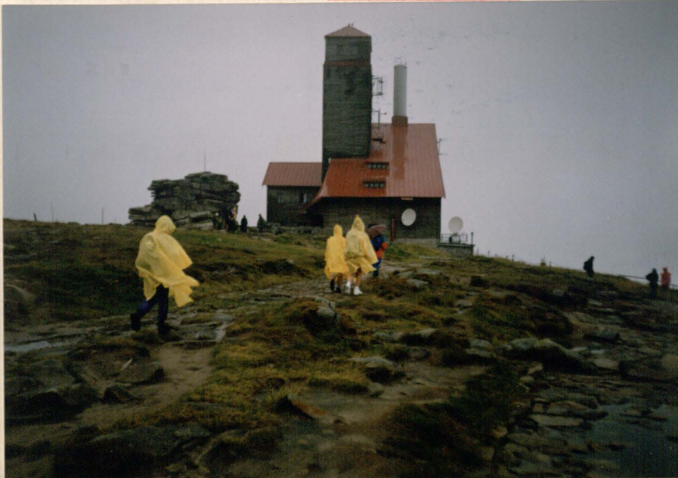
Stacja przekaznikowa nad Śnieżnymi Kotłami.
