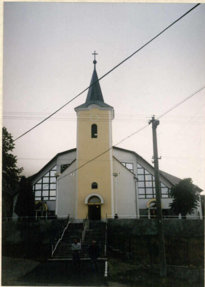
11 września 1995r. Kościół w Kamienicy - wielokrotnie przebudowany.
